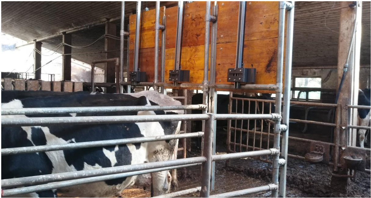
Montaža zadnjih zapor
