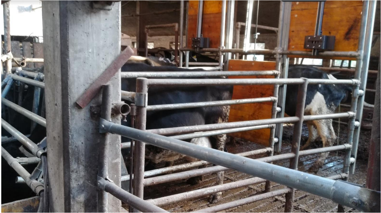
Montaža zadnjih zapor
