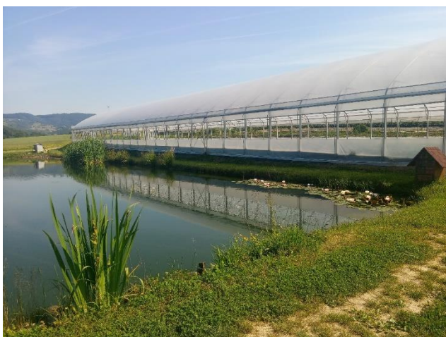
Slika 4: Akumulacija, ki se polni iz streh rastlinjakov, gospodarskih in stanovanjskih objektov, foto Andreja Brence
