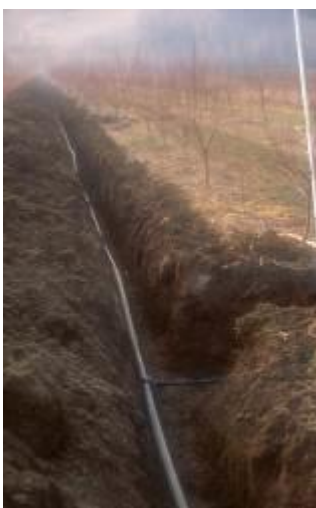
Slika 31: Izgradnja stabilnega oroševalnega sistema.
