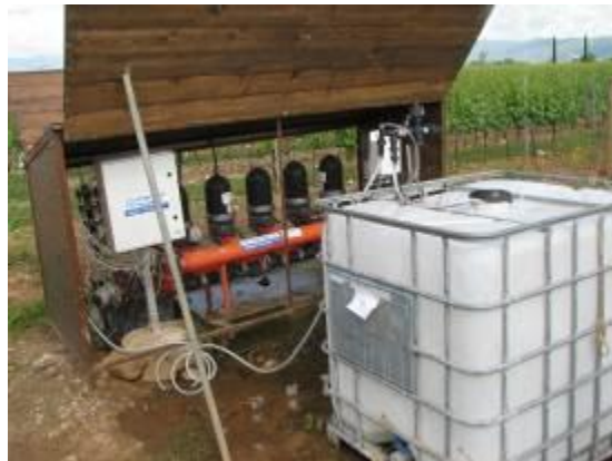
Slika 43: Več povezanih lamelnih ali diskastih filtrov
