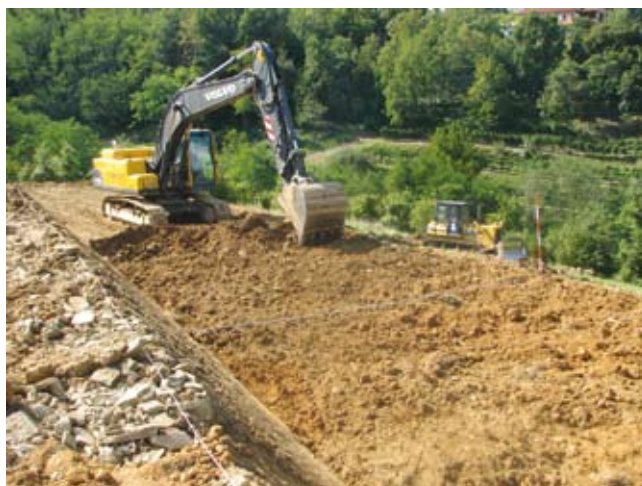
Slika 22: Prekopavanje teras z bagrom
