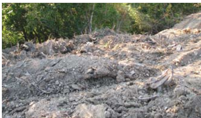
Slika 4: Nalaganje štorov v deponijo na rob parcele
