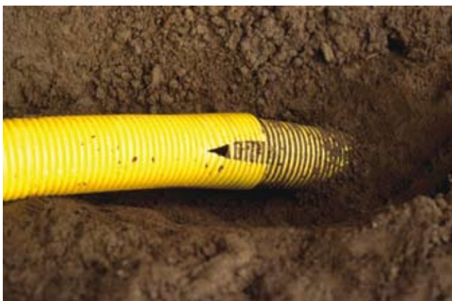
Slika 21: Popravljanje pretrgane drenažne cevi
