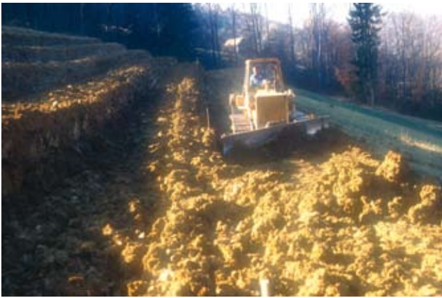
Slika 23: Izdelava teras ali obdelovalnih poti na točno določeno širino terasne ploskve z buldožerjem
