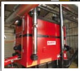
1 Kotel na lesne sekance 1.500 kW daljinsko ogrevanje Kozje
